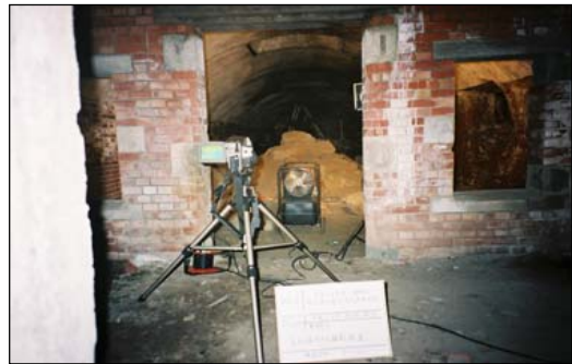
写真-7 赤外線カメラの設置状況
