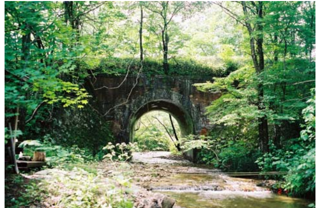
写真-1 小笹川橋梁【土木学会：選奨土木遺産】
