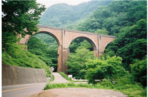
写真-2 碓氷第三橋梁【呼称：めがね橋】
