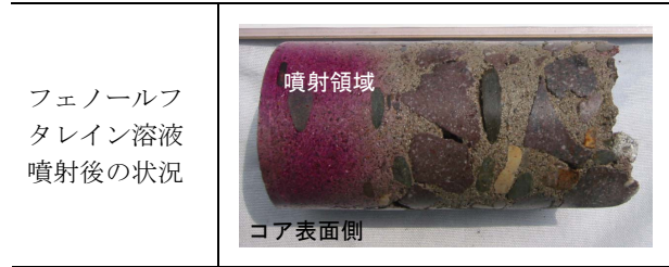
写真-4 中性化試験後の状況
